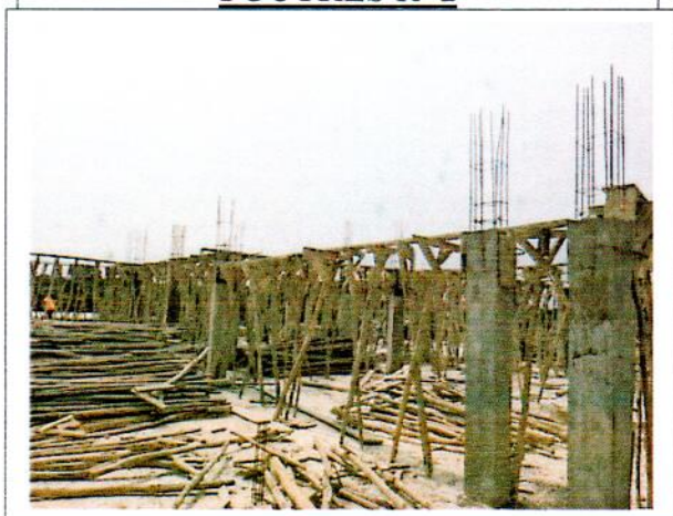
POSE DES FERRAILLAGE DE POUTRES R+2
