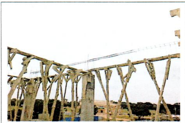
POSE DES FERRAILLAGE DE POUTRES R+2
