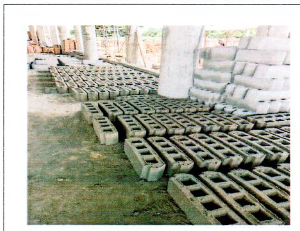
FABRICATION DES HOURDIS R+2
