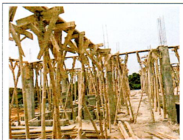
POSE DES FONDS DE POUTRE R+2
