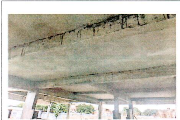
ENDUIT SOUS DALLE RDC
