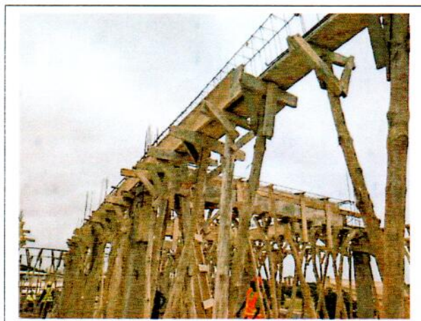
COFFRAGE DES POUTRES R+2
