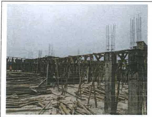
POSE DES FONDS DE POUTRE R+2
