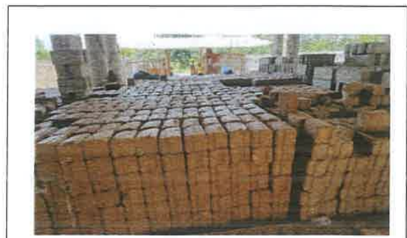
FABRICATION ET STOCKAGE DES BTC
